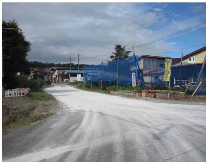
消石灰帯の設置
