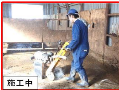
牛床の溝切り施工の状況
