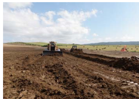
ブルドーザによる切盛・整地
