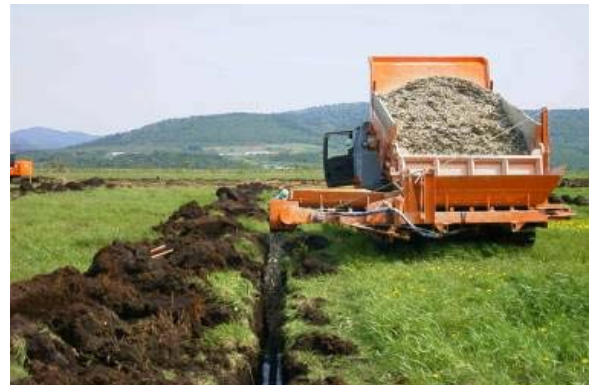
暗きょ排水疎水材投入状況
