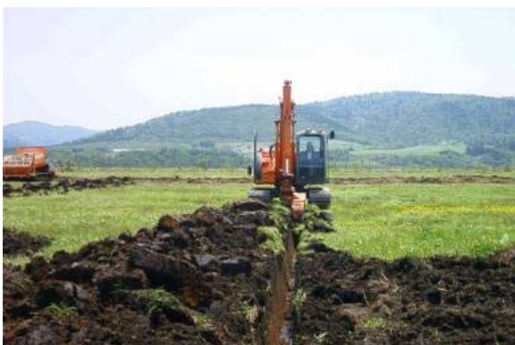
暗きょ排水溝掘削状況
