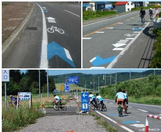
自転車走行環境の改善 (路面標示・案内看板の設置)
