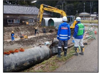
【復旧工事の状況】
