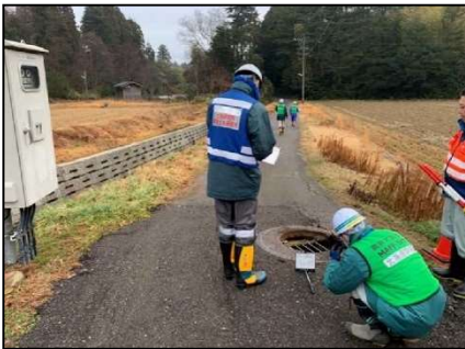
【農業集落排水施設の調査】
