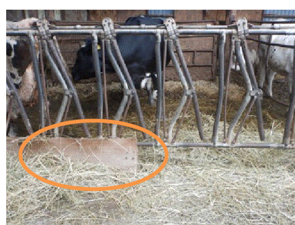
飼槽隔壁の設置
