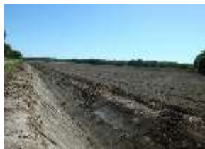
明渠の床ざらい （中標津町）
