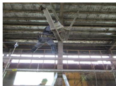
写真5 送風機の角度調整
