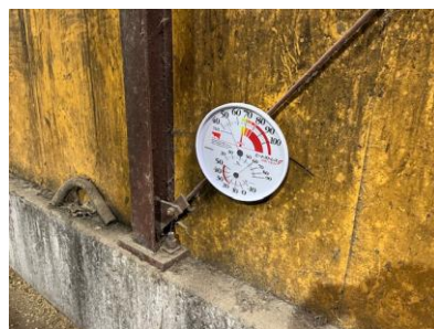
写真3 牛舎内に設置されたヒートストレスメーター
