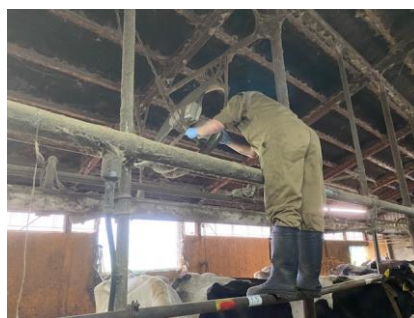
写真4 送風機の清掃
