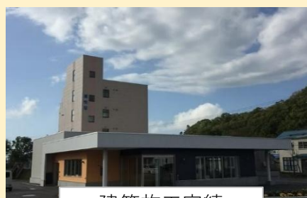
建築施工実績
