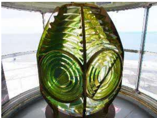
現在宗谷岬灯台で使われているレンズは、英国チャンス・ブラザーズ社製。とても重いレンズは水銀に浮かべられ30秒で1回転する。
