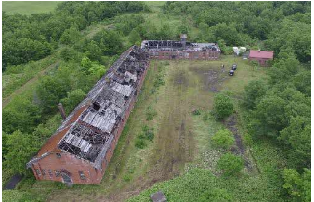
現存する赤れんが通信所の全景。写真手前からA棟、B棟、C棟と並ぶ。歴史的遺産も厳しい自然環境にさらされ老朽化が著しい。現在は徐々に補修を行っている。
