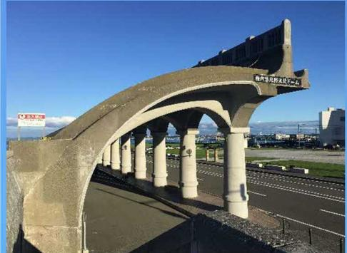
半アーチ状のデザインは、稚内市の強風と高波を克服するためのもので高さ13.6m、柱の内側から壁まで8m、総延長427m、柱の数は70本。世界でも類のない建設物として注目を浴びている建造物であり北海道遺産に指定されている。
