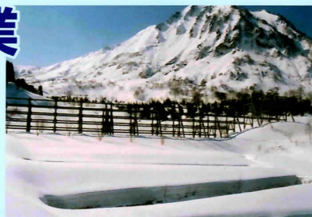
新潟県糸魚川市大字柵口 減勢工
