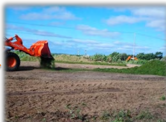
② 土がタイヤに付くのを防ぐため、ダンプ荷下ろし時にショベルが後退する所まで草を敷く
