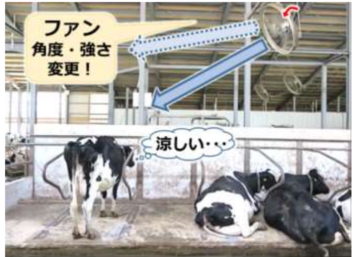
写真1 牛床上の設置したファン
