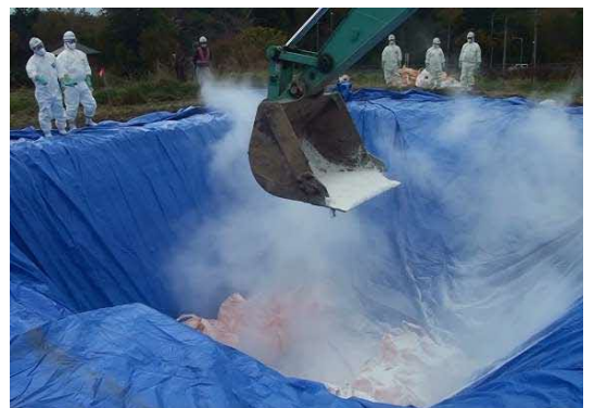
埋却溝への消石灰散布
