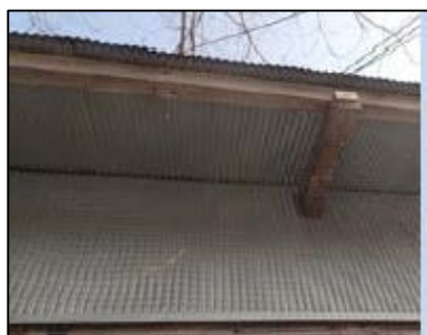
防鳥ネットの設置・修繕
