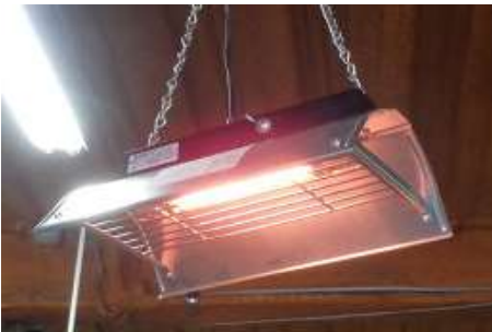
写真4：吊り下げ式ヒーター (单相 200v-300w)
