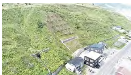
瀬川地先 林地荒廃防止施設災害復旧事業(礼文町)
