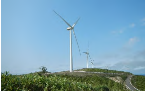
風力発電施設の設置（稚内市）
