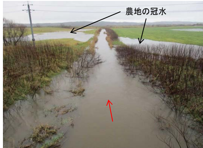
令和2年11月の協進橋下流の浸水被害
