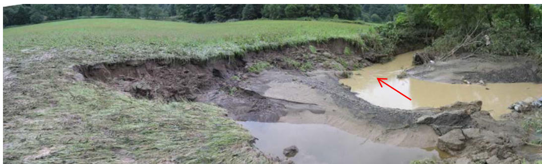
平成 22 年 8 月の二十三号川 きつこう 桔杭橋下流の浸水被害（河岸欠壊による農地被害）
