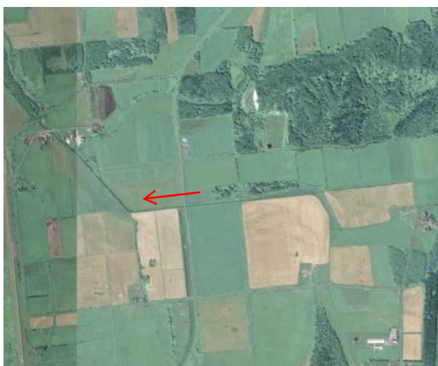
優先整備区間（大礼橋上流）
