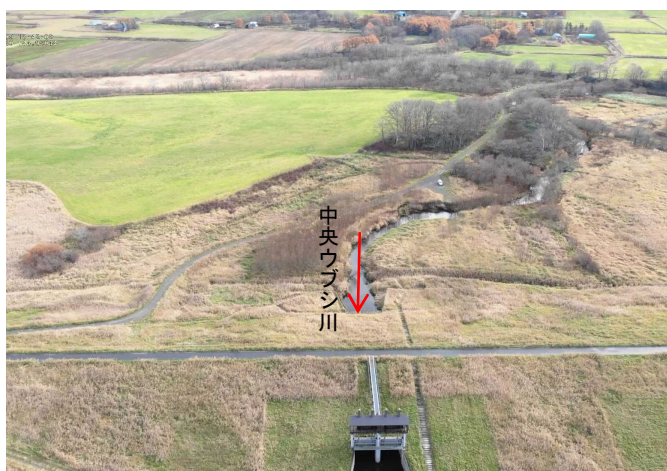
優先整備区間（作返1号樋門上流）
