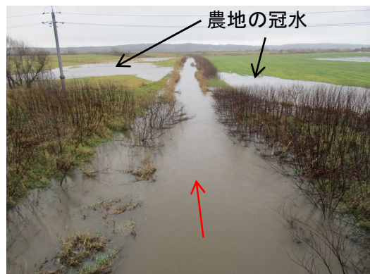
原子の沢川 協進橋下流の浸水被害
