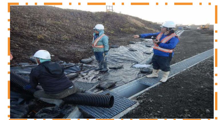
現場にて施工管理
