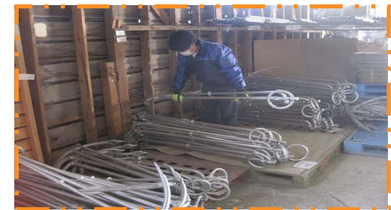
アンカーをまとめている
