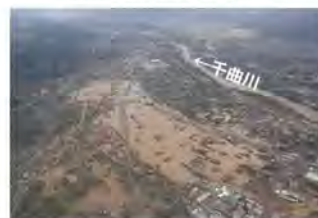
⑨千曲川における浸水被害状況 (長野県長野市)
