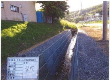
護岸整備(準用区間) (稚内市)
