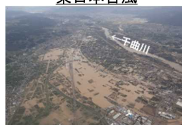
⑩千曲川における浸水被害状況 (長野県長野市)
