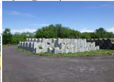
防災資材の備蓄施設の整備 (宗谷総合振興局)
