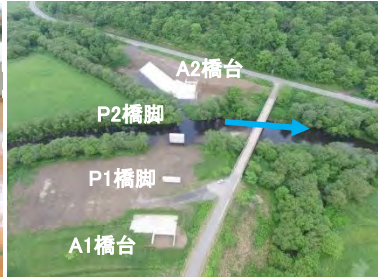
橋梁架替(一已内橋) (宗谷総合振興局)
