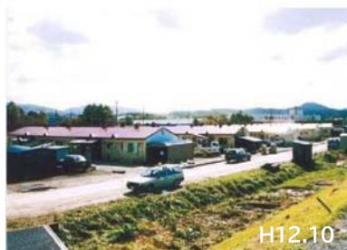
浸水被害箇所
