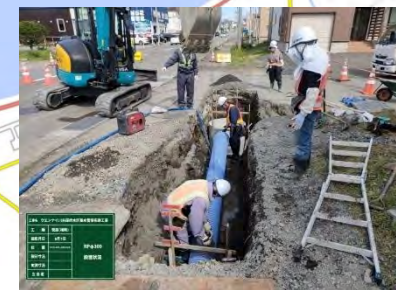
雨水管渠布設工事 (稚内市)
