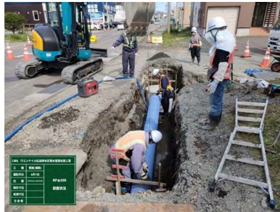
ウエンナイ川右岸排水区雨水管渠布設工事
